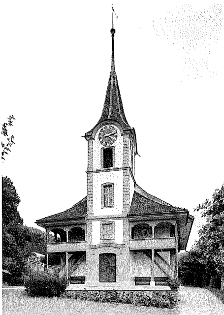
Abb. 233: Ludwig Emanuel Zehender, als Werkmeister auf dem Land vor allem für zahlreiche Neu- und Umbauten von Pfarrhäusern bekannt, schuf mit der Kirche Krauchthal ein kleines Meisterwerk, das den barocken Kirchenbau mit Einturmfassade und dreiseitig geschlossenem Saal geschickt der ländlichen Baukultur anpasst.
